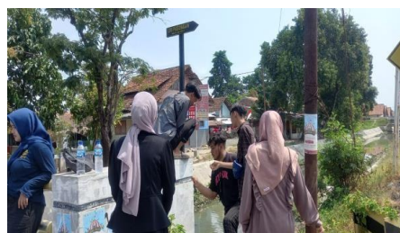
Sumber : Hasil Pengabdian Masyarakat Gambar 5. Proses Pemasangan Plang Jalan
